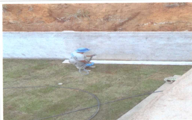
PINTURA DO MURO DA ÁREA EXTERNA
