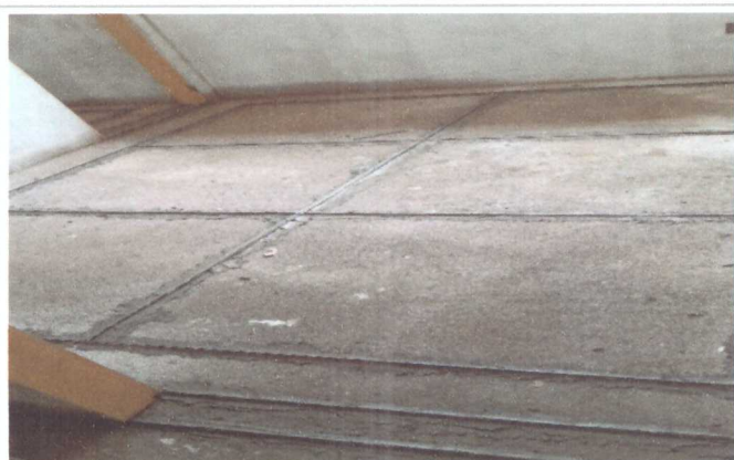
EXECUÇÃO DE GRANITINA
