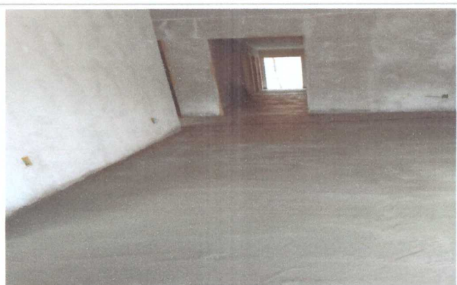
EXECUÇÃO DE GRANITINA
