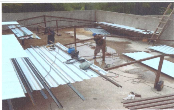
EXECUÇÃO DE TELHADO
