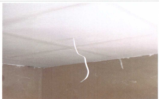
FORRO DE GESSO
