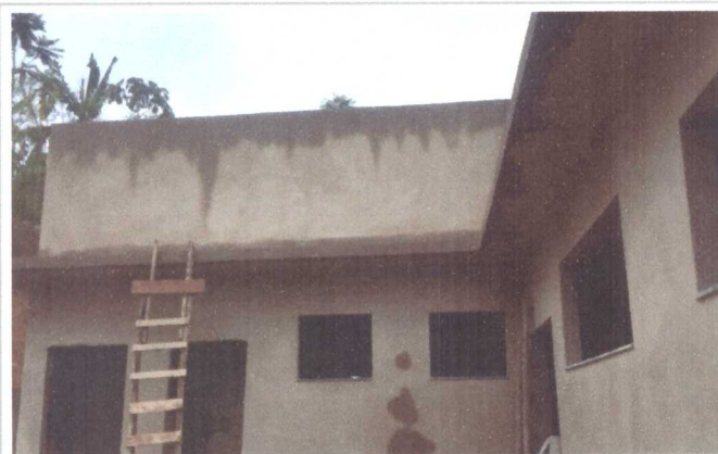
ASSENTAMENTO DE PEITORIL
