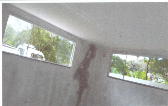
INSTALAÇÃO DE JANELAS
