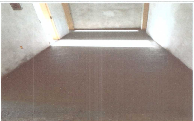
EXECUÇÃO DE GRANITINA
