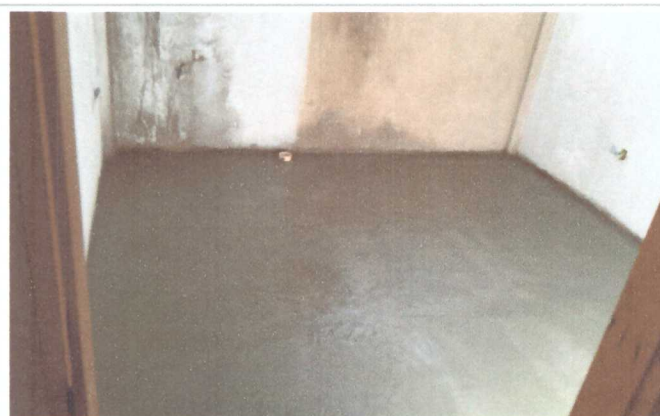
EXECUÇÃO DE GRANITINA
