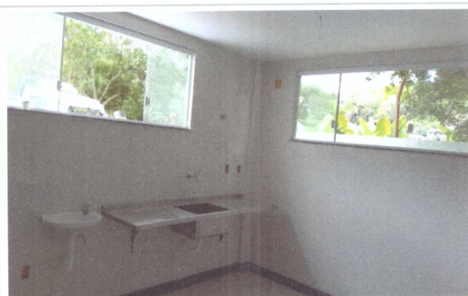
INSTALAÇÃO DE PIA E BANCADA DE INOX
