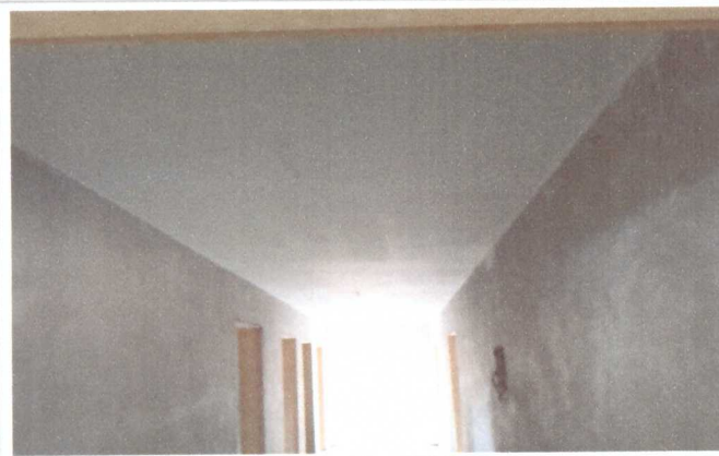
EMASSAMENTO DO TETO
