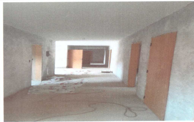
INSTALAÇÃO DE PORTAS
