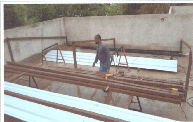
EXECUÇÃO DE TELHADO
