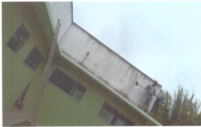
PINTURA DA OBRA
