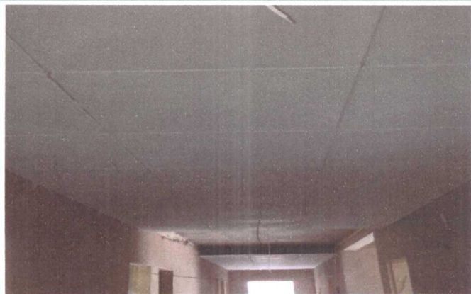
FORRO DE GESSO
