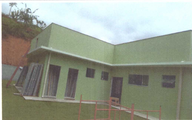
PINTURA DA OBRA
