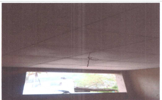
FORRO DE GESSO
