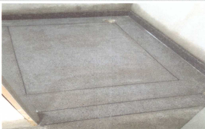
EXECUÇÃO DE GRANITINA
