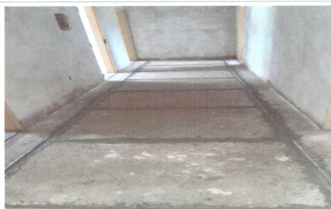
EXECUÇÃO DE GRANITINA
