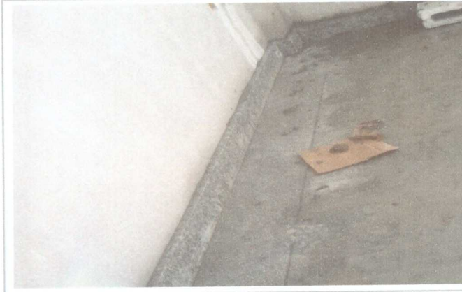
ASSENTAMENTO DE RODAPÉ
