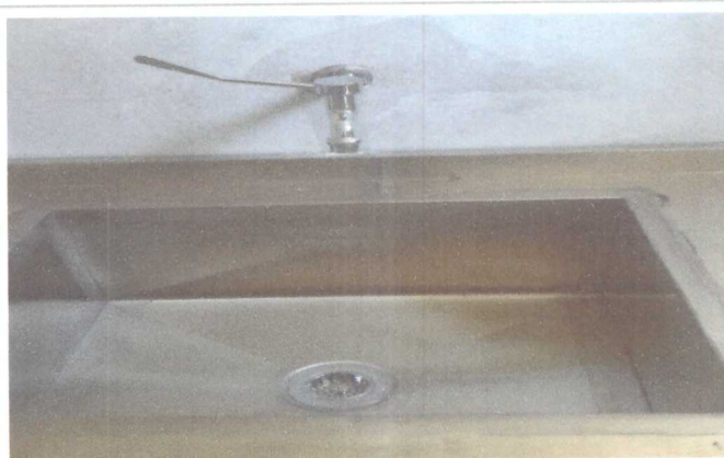
INSTALAÇÃO DE PIA
