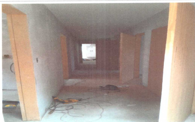
INSTALAÇÃO DE PORTAS
