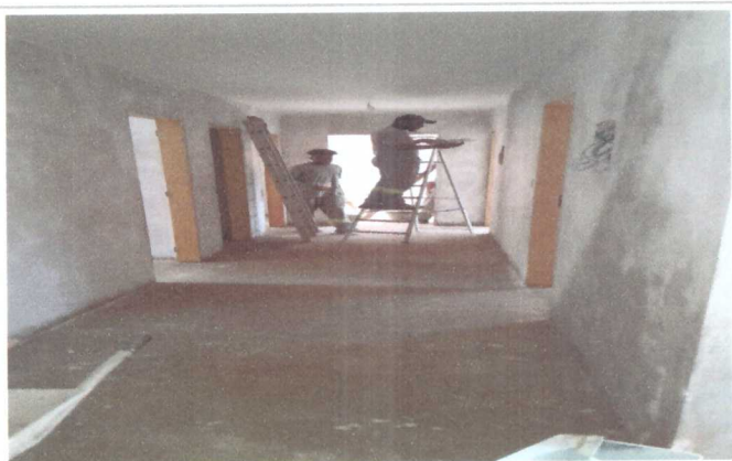
EMASSAMENTO DO TETO
