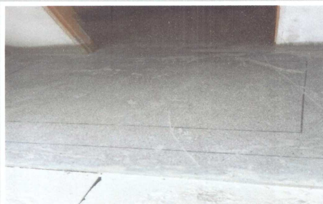
EXECUÇÃO DE GRANITINA
