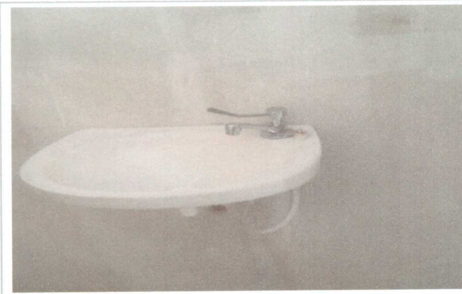
INSTALAÇÃO DE PIA
