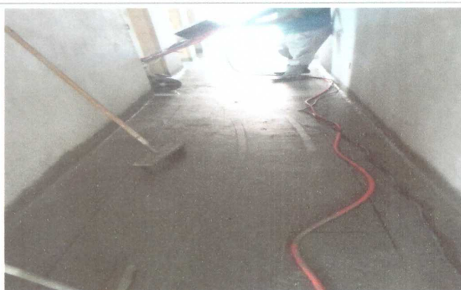
EXECUÇÃO DE GRANITINA
