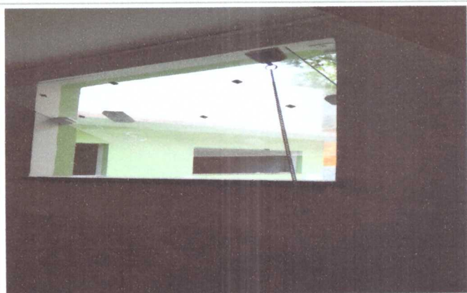
INSTALAÇÃO DE BASCULANTE
