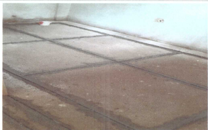
EXECUÇÃO DE GRANITINA
